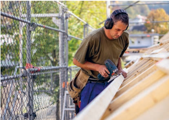
Bei der Erneuerung des Dachs eines Mühlengebäudes 2018
